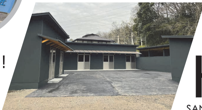
和光大学作業所・倉庫等建設工事
